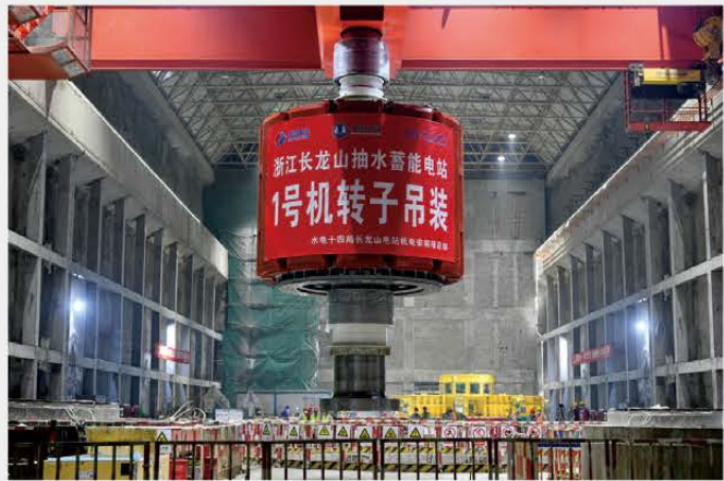
2020年10月，东方电机研制的国内最高水头浙江长龙山抽水蓄能电站首台机组转子吊装成功。
